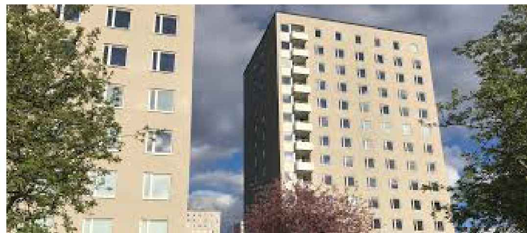
Figura 28: Reforma em edificação em Valla Torg.
