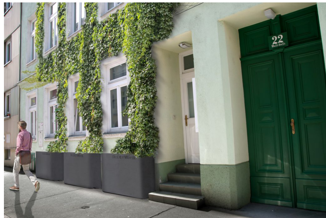
Figura 31: Instalação dos módulos BeRTA em uma fachada.
