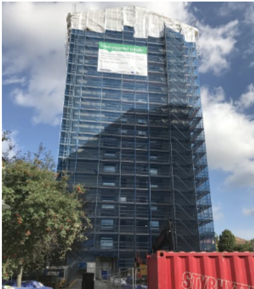
Figura 26: Reforma em edificação em Årstakrönet.
