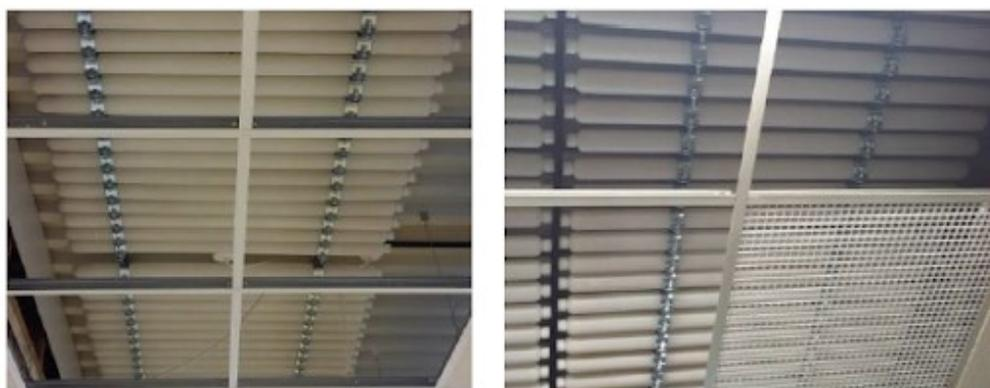
Figura 6 - Tubos com material PCM. Fonte: Ahmed, Mateo, Garcia (2017).
